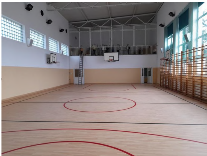
Rysunek nr 54. Zmodernizowana sala sportowa w Publicznej Szkole Podstawowej im. C.K. Norwida w Dąbrówce
