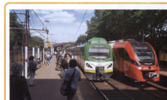
Rys. 2.7 Infrastruktura kolejowa PKP Powiśle w Warszawie
