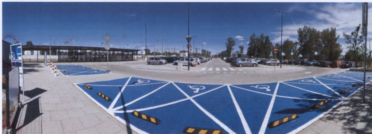
Rys. 2.3 Parking P+R w Nowym Dworze Mazowieckim
