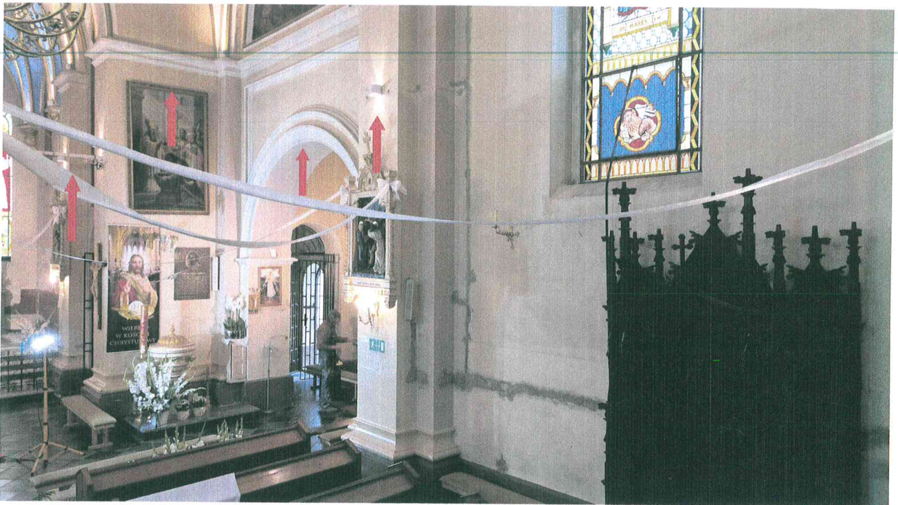
4. Dolna część portalu bocznego z wejściem do kaplicy pogrzebowej. Zakres ścian podlegających, planowanym pracom oznaczono czerwoną strzałką.
